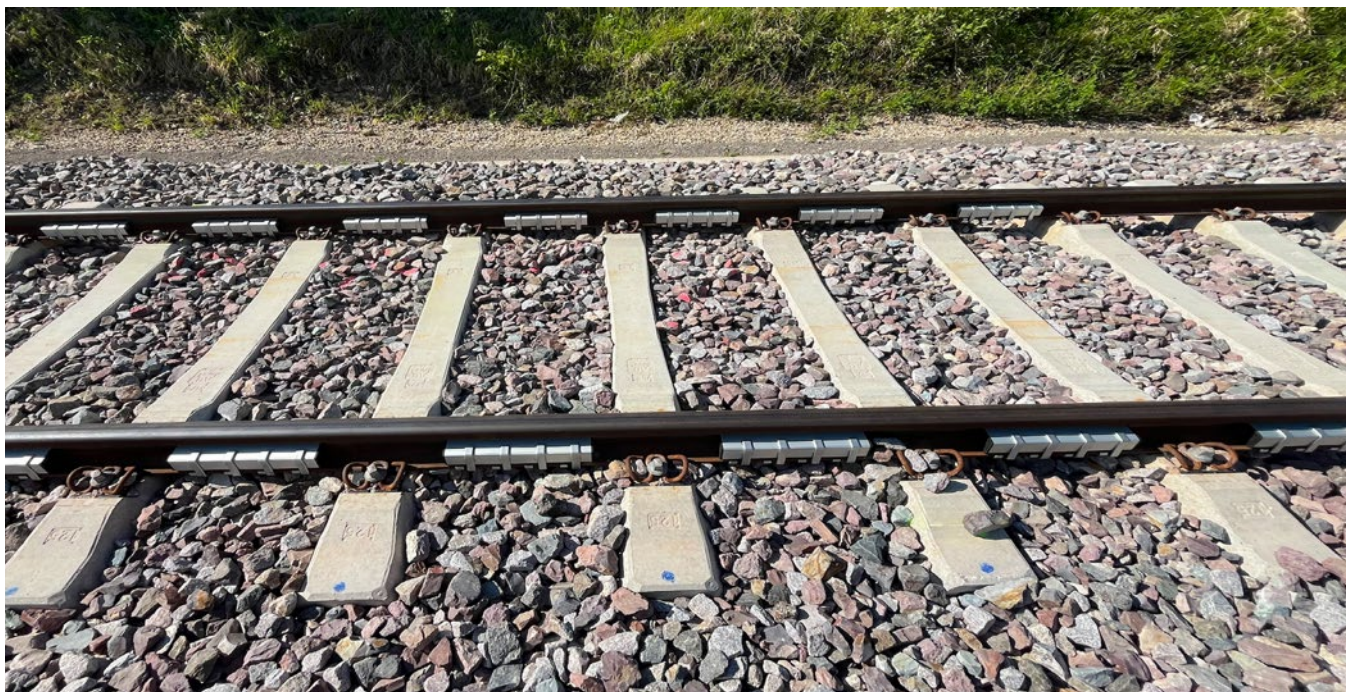
Kleines Bauteil, große Wirkung: Schienenstegdämpfer im Einsatz
