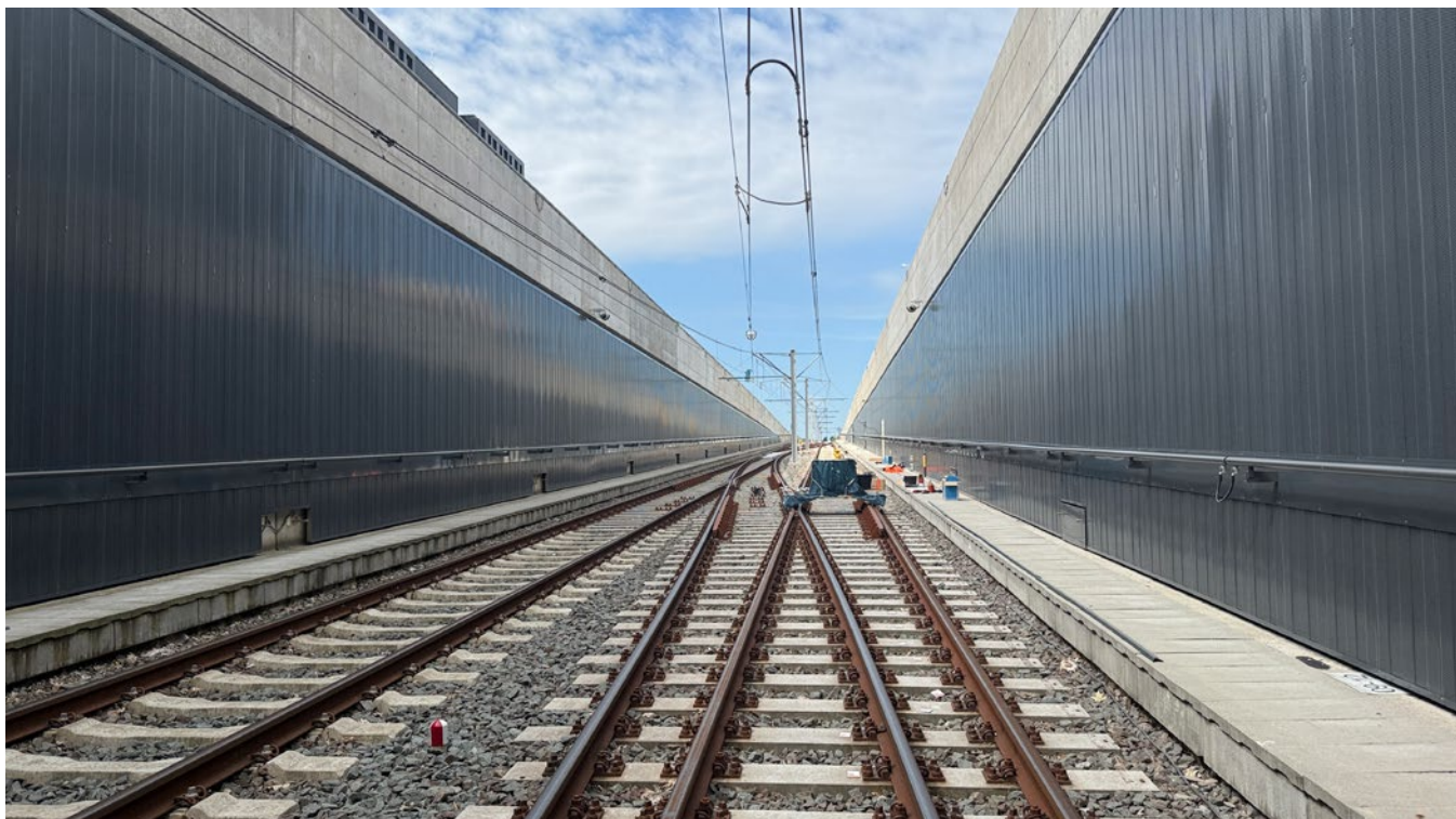
Fast fertig – Blick aus dem Tunnel auf Düsseldorfs neue Stadtbahnverbindung
