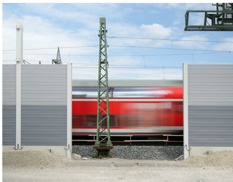
Bau von Lärmschutzwänden (bei Forchheim)
