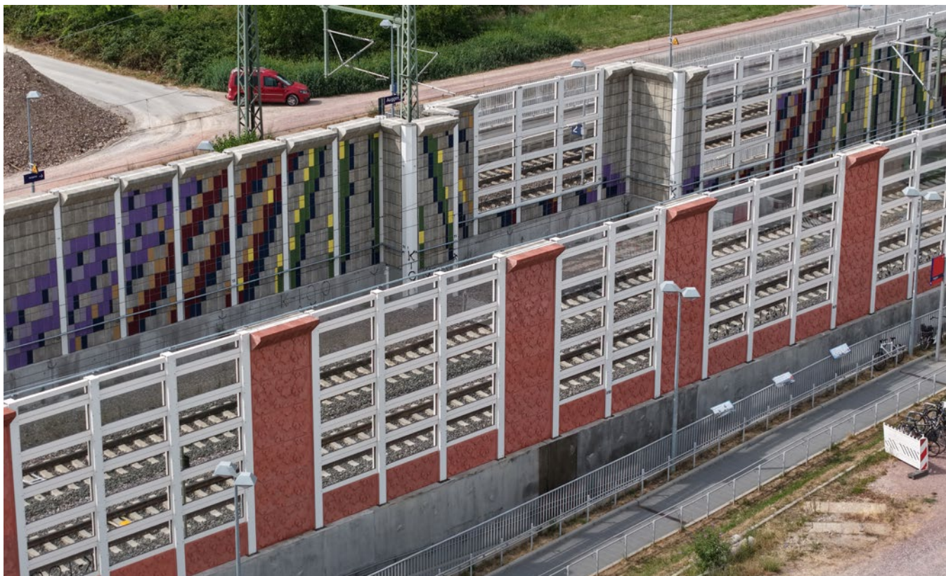
Technik trifft Gestaltung: In Auggen verbinden individuell gestaltete Holzbetonelemente und transparente TAP-RAIL®-Elemente wirksamen Bahnlärmschutz mit regionaler Identität und architektonischer Qualität.
