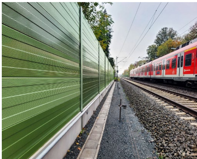
Grün in jeder Hinsicht: Diese FONOCON-Lärmschutzwand wurde mit Energie aus regionalem Hackgut gefertigt.
