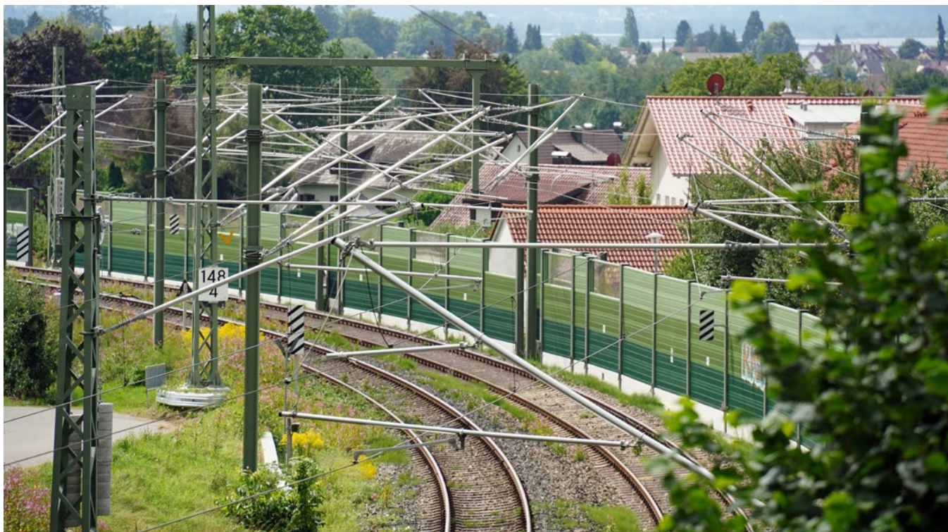
Lärmschutzwand in Bodolz / Bayern
