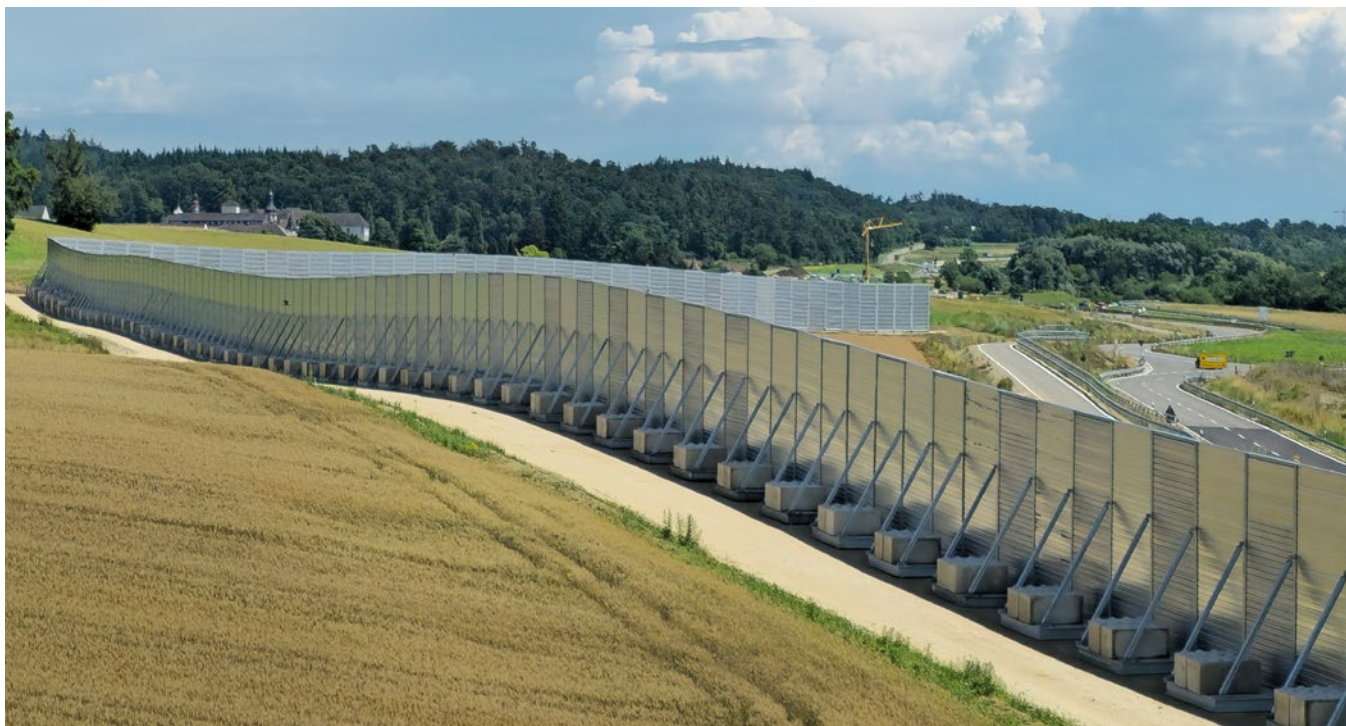
Baumaßnahme Röhrenbergtunnel B 33 zwischen Allensbach und Konstanz
