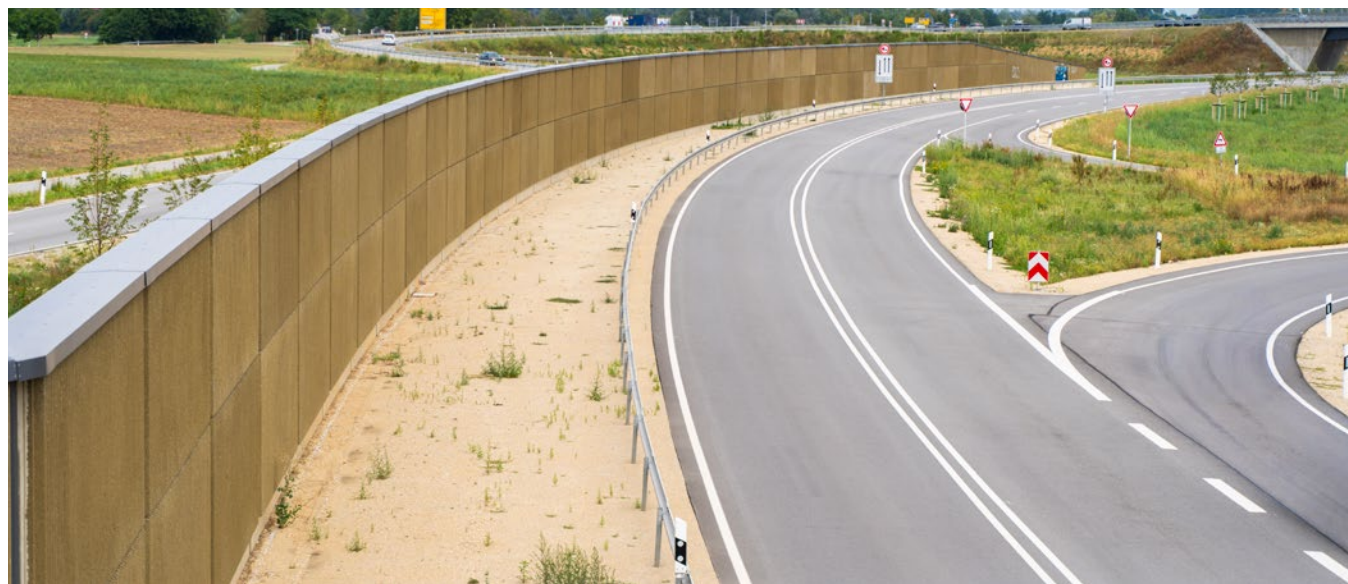
Lärmschutzprojekt an der B16 im bayerischen Manching.
